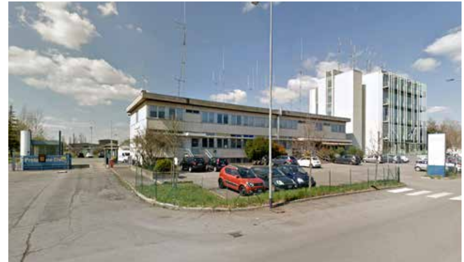
Il Centro Unificato Provinciale di Protezione Civile in via del Taglio a Parma
