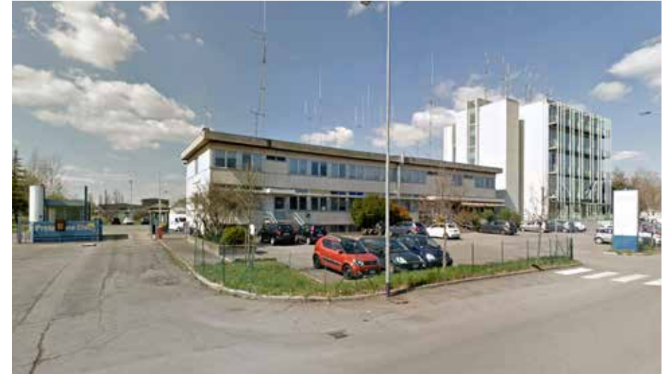
Il Centro Unificato Provinciale di Protezione Civile in via del Taglio a Parma
